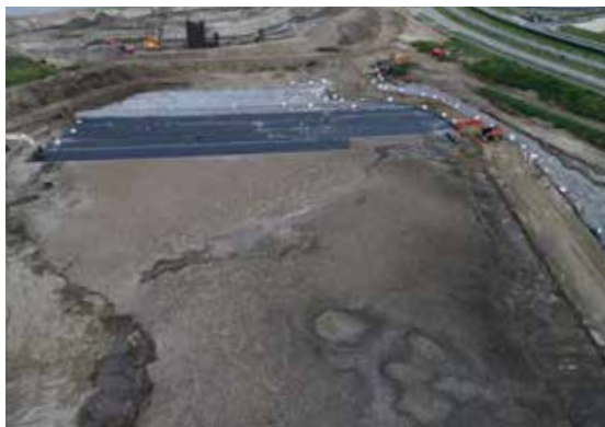
Afb. 43 Afdek met HDPE-folie en kleimatten.
