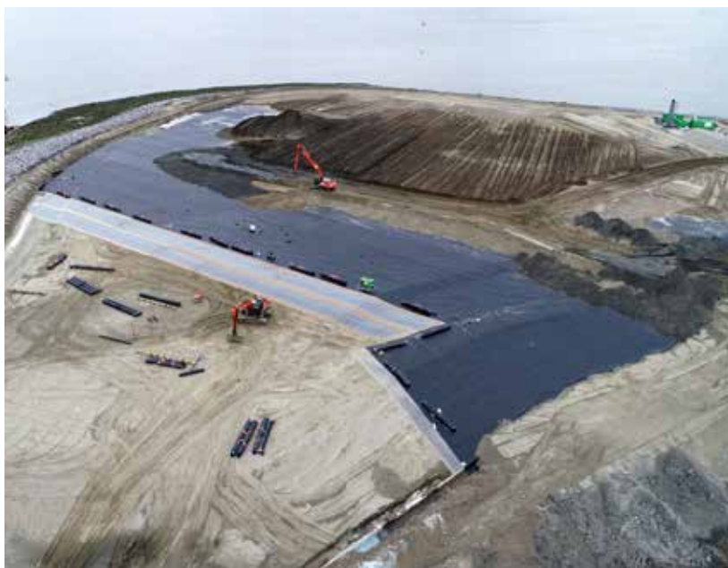
Afb. 41 Afdek isolatie fortzone.
