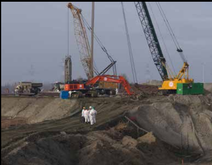
Afb. 27 Plaatsen damplanken in CB wand.
