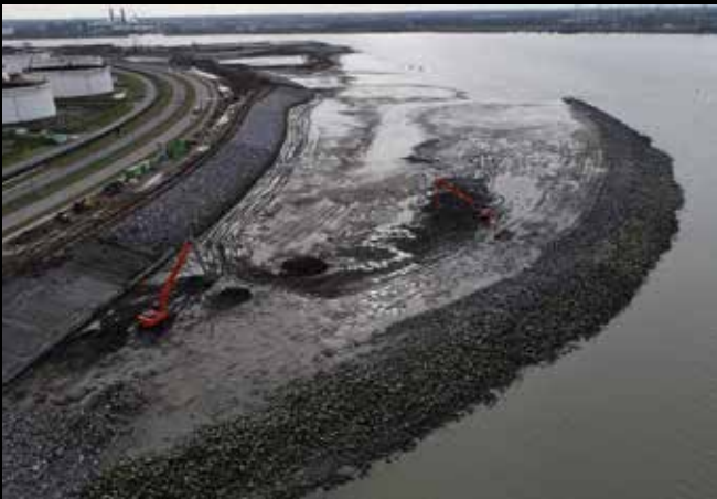
Afb. 73 Wegwerken overhoogte (aanvulling tussen Schelde- en kribbedijk).
