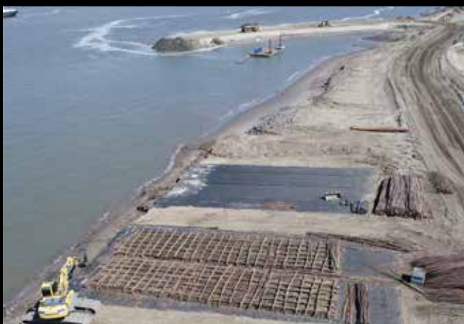
Afb. 67 Prefab zone zinkstukken.
