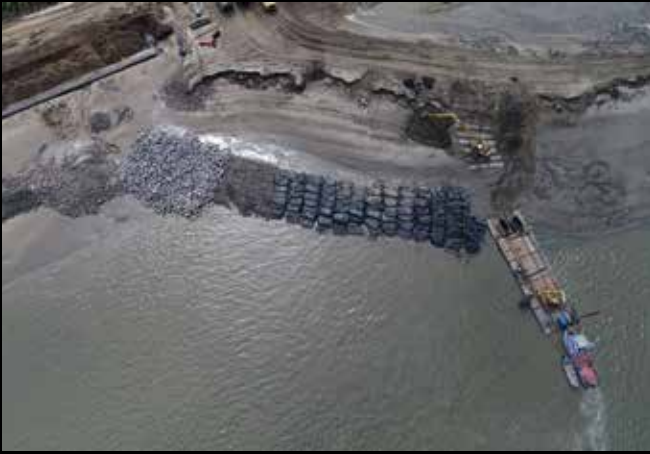
Afb. 64 Plaatsen geotextiel elementen na profilering dijk.
