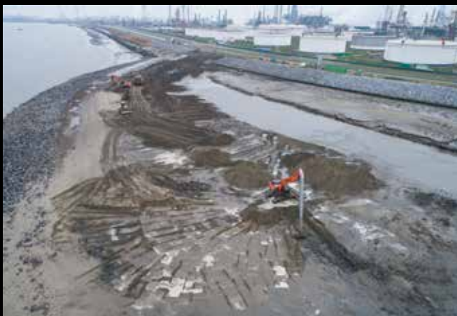
Afb. 74 Wegwerken overhoogte (aanvulling tussen Schelde- en kribbedijk).
