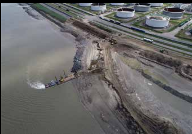
Afb. 63 Plaatsen geotextiel elementen na profilering dijk.
