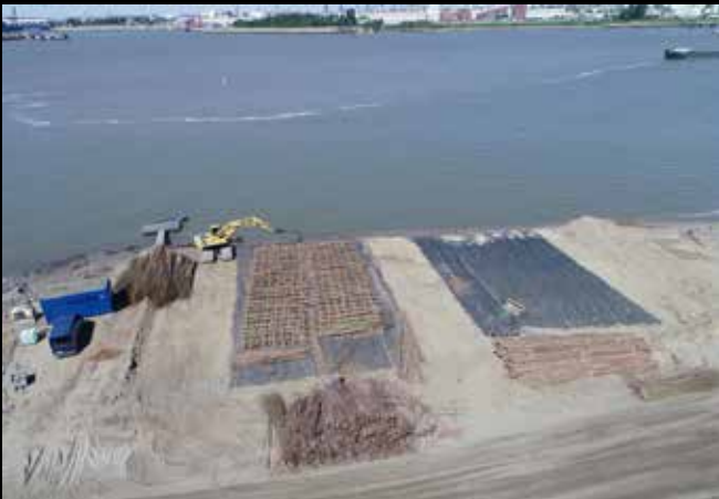
Afb. 65 Prefab zone zinkstukken.
