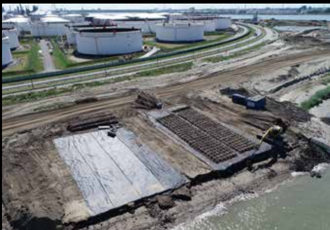
Afb. 66 Prefab zone zinkstukken.
