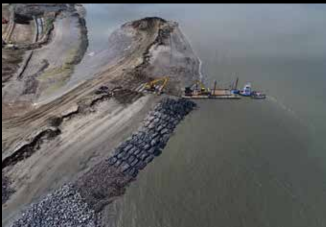
Afb. 62 Plaatsen geotextiel elementen na profilering dijk.
