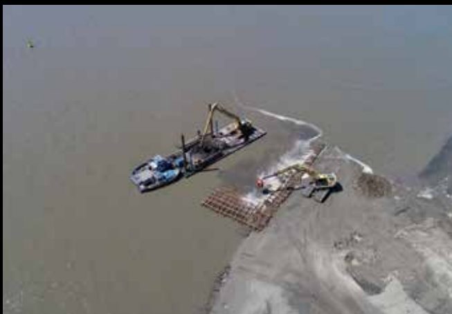
Afb. 70 Plaatsen en ballasten zinkstukken.
