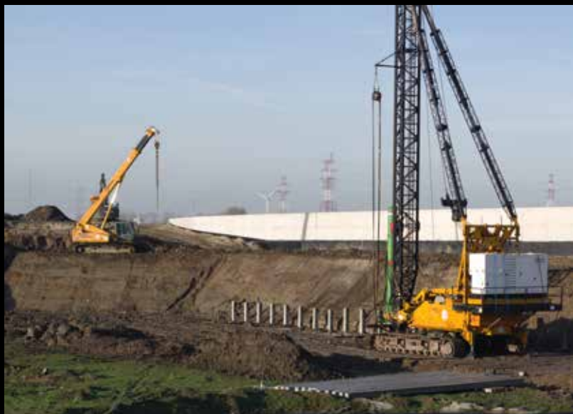
Afb. 33 Plaatsen betonnen heipalen.
