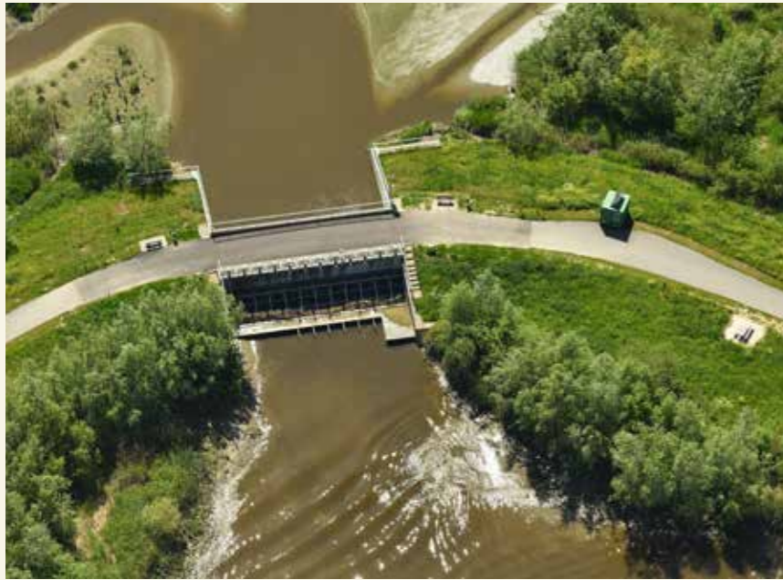
De in- en uitwateringssluis aan het gecontroleerd overstromingsgebied met gereduceerd getij Bergenmeersen (Wichelen).
