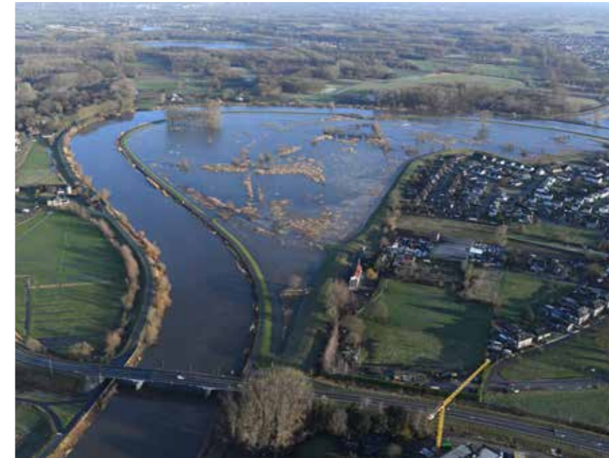
Het gecontroleerd overstromingsgebied Bergenmeersen (Wichelen) vangt water op tijdens het stormtij van januari 2017.
