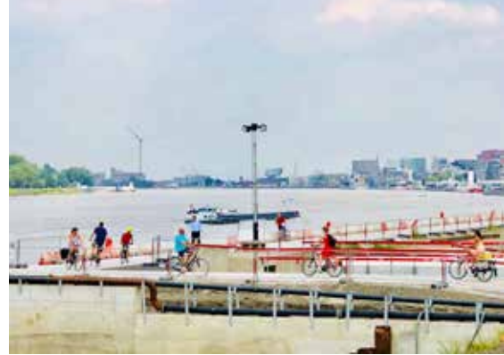
Tijdelijk fietspad over dijk
