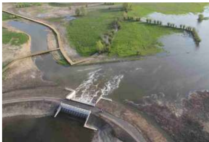
4. in- en uitwateringsluis
