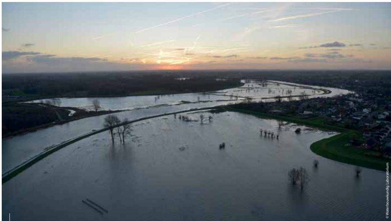
Het gebied Bergenmeersen (Wichelen) beschermd tijdens de sinterklaasstorm (december 2013) de regio tegen overstromingen.
