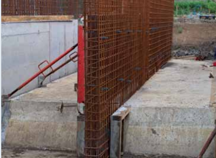
Afbeelding 7.5. Bekisting en wapening van de wanden
