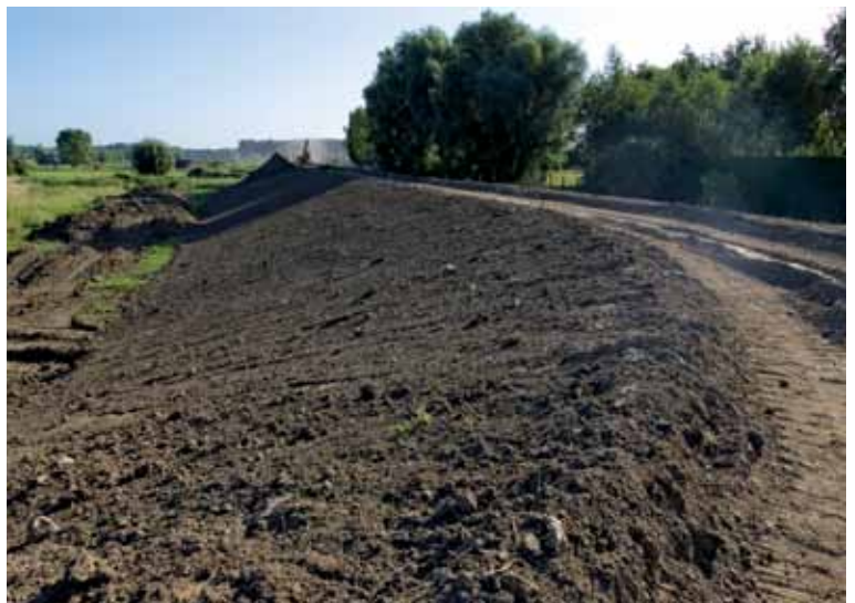
Afbeelding 7.2. Grondwerken: ophoging en verbreding van ringdijk
