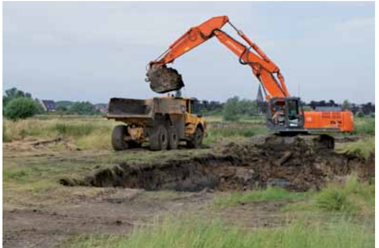
Afbeelding 7.1. Grondwerken: start uitgraven van geulaanzet
