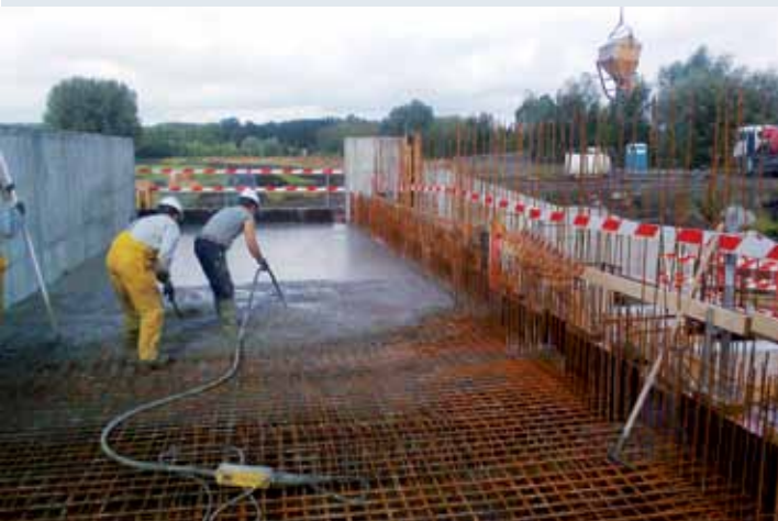
Afbeelding 7.6. Vloerplaat en damplanken tegen onderloopsheid
