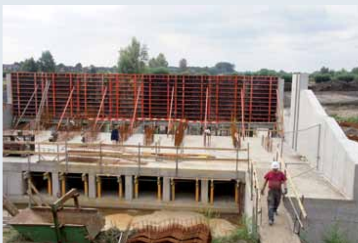
Afbeelding 7.9. Bekisting en wapening van de bovenbouw
