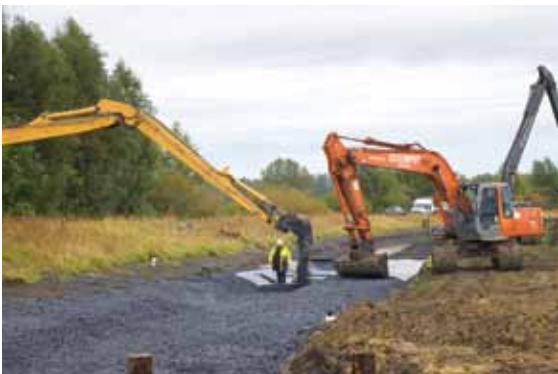
Afbeelding 7.12. Aanleg dissipatiegracht met open steenasfalt
