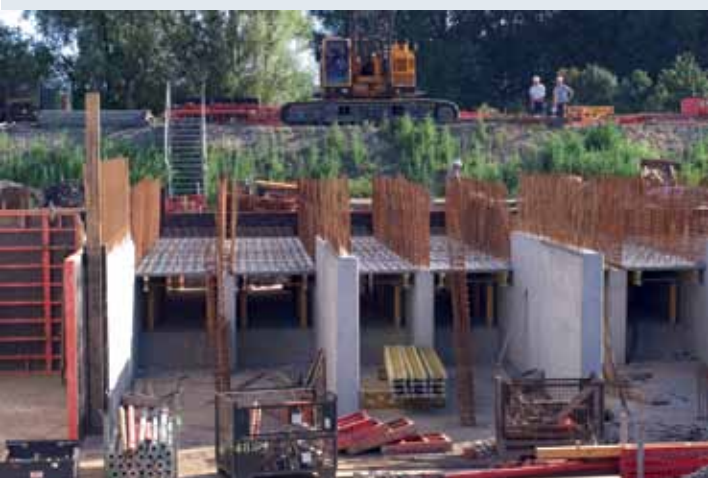
Afbeelding 7.8. Bekisting en wapening van de tussenplaat van de in- en uitwatering
