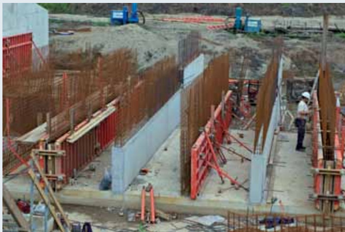
Afbeelding 7.7. Betonning van de wanden
