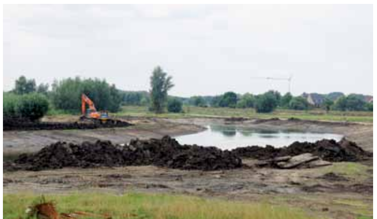
Afbeelding 7.3. Grondwerken: einde uitgraven geulaanzet
