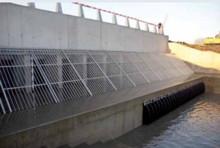
Afbeelding 7.10. Installatie van de randinfrastructuur
